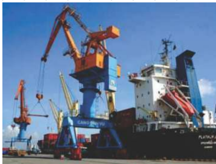
CÔNG TRÌNH BẾN CẢNG SỐ 2 CẢNG ĐÌNH VŨ Berth No.2, Dinh Vu Port - Haiphong
